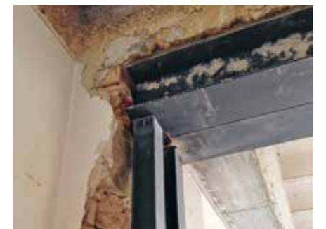
Von oben nach unten: Aula nach dem Rückbau Zwischendecke/Büroräume
